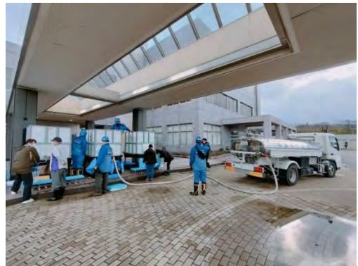
写真2 給水車から仮設水槽に給水する様子
