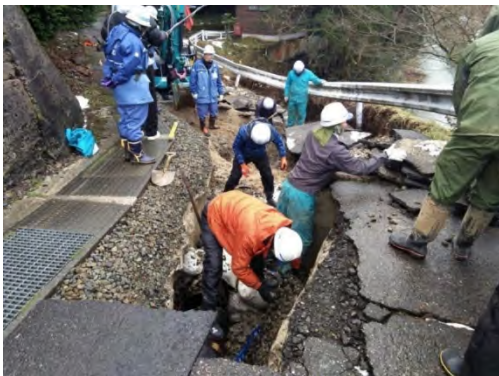
写真3 応急復旧作業の様子
