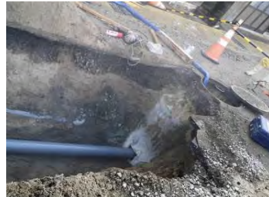
写真7 バイパス管の施工
