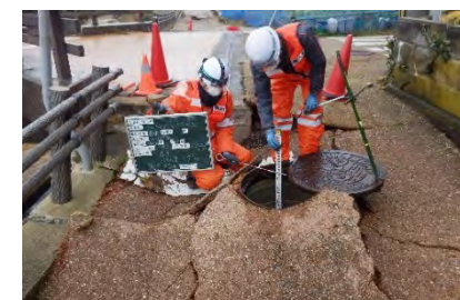
写真3 マンホール調査
