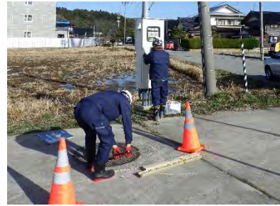
写真5 マンホールポンプ調査
