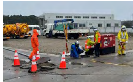
写真6 仮設排水ポンプの設置
