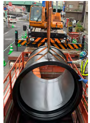
口径1350mm配水管更新工事
