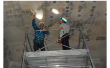
配水池劣化状況調査の様子
