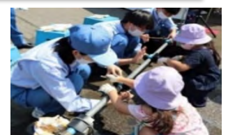
漏水修理体験の様子 (水道週間)
