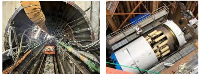
導水管 シールドマシンによる掘削の様子
