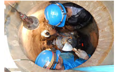
仕切弁点検調査の様子
