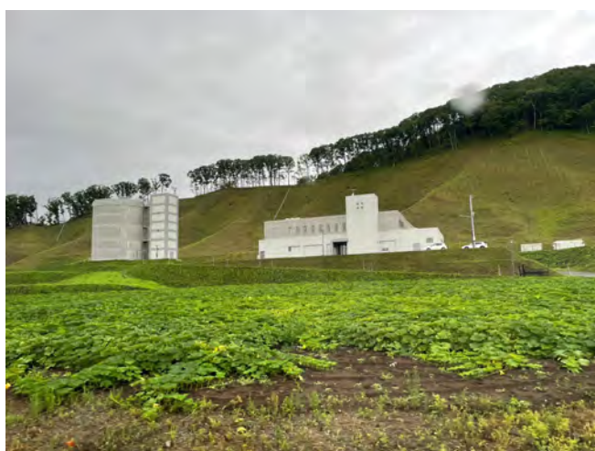
(富里浄水場と土砂崩れの跡)
