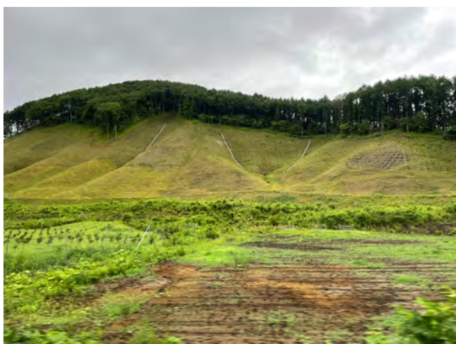
(大規模な土砂崩れの跡)
