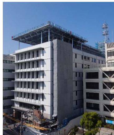
< 消防本部庁舎 >
