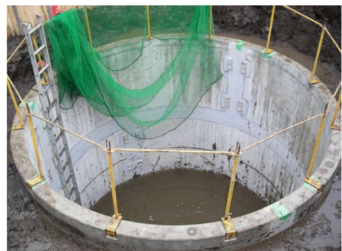
<防火水槽新設工事>
