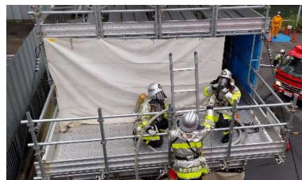
<仮設訓練施設>
