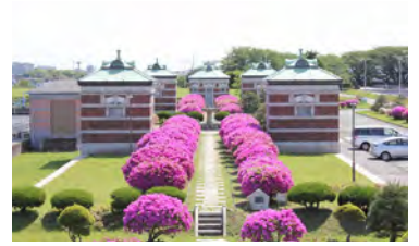
西谷浄水場濾過池整水室上屋3号棟
