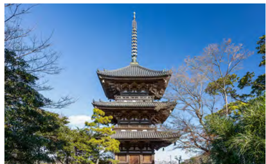
[図1-35] 旧燈明寺三重塔
