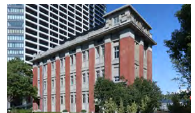
旧横浜生糸検査所附属倉庫事務所
