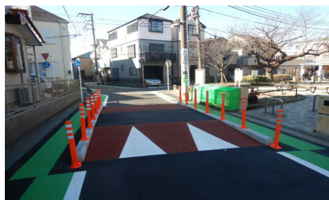
ハード整備の例（ポール及びハンプの設置）
