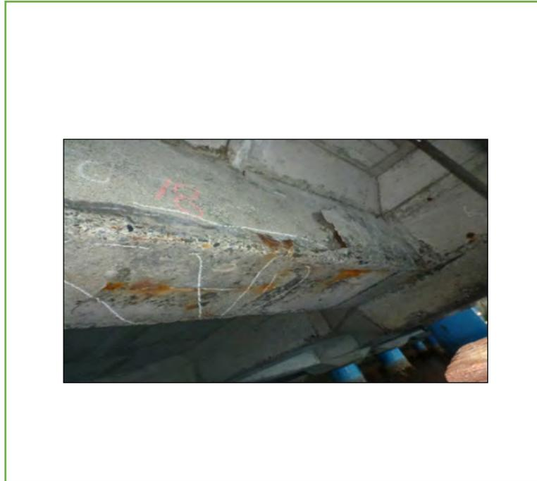
岸壁の栈橋下面の劣化状況
