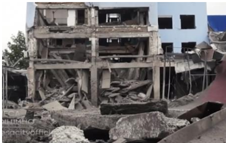
ロシアの攻撃により 建物が破壊された様子
