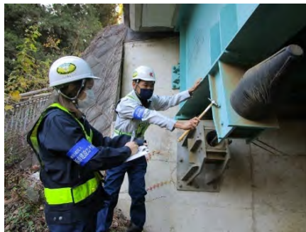
関係団体による被害状況緊急調査の訓練 (神奈川県測量設計業協会横浜支部) (横浜市地質調査業協会) (横浜市建設コンサルタント協会)
