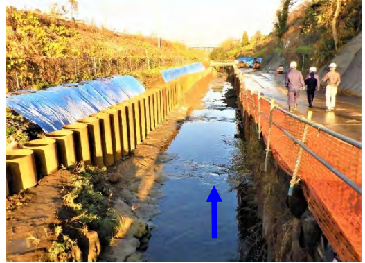
護岸改修、橋梁架替え、用地補償 (今井川：保土ヶ谷区権太坂一丁目)
