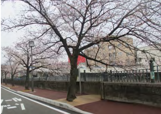
大岡川プロムナードの舗装改修
