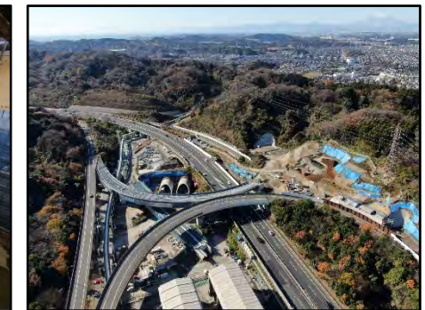
釜利谷JCT改築工事 （金沢区釜利谷町）
