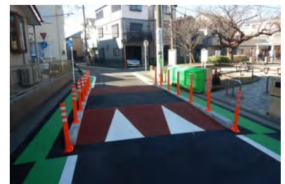
通学路の交通安全対策 (速度抑制対策:南区大岡小学校周辺)
