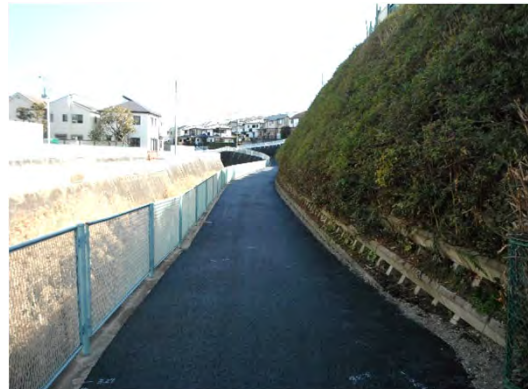
岩川沿いルートの舗装新設
