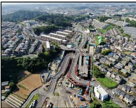
公田IC築造工事 （栄区公田町）
