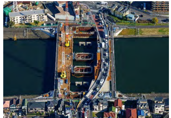
老朽橋架け替え: 末吉橋(鶴見区)
