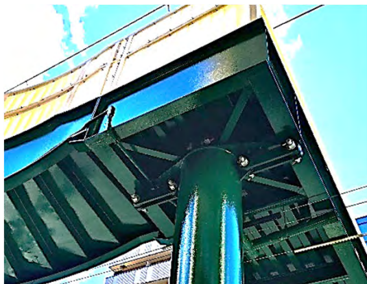
通町歩道橋(南区):落橋防止装置 令和4年11月完成
