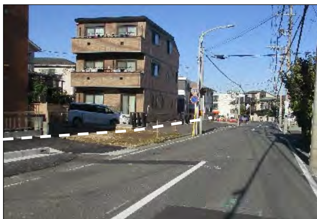
歩道整備 市道上大岡第149号線・第168号線(南区大岡五丁目)
