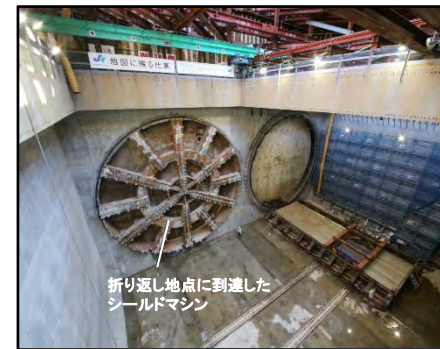
桂台トンネル工事 （栄区上郷町）
