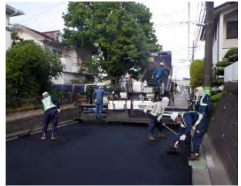
舗装修繕工事の状況(泉区)
