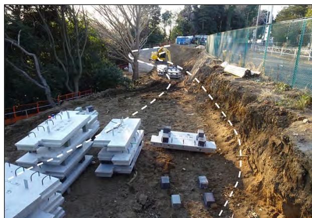
道路整備 市道三ツ沢第398号線(保土ヶ谷区鎌谷町)
