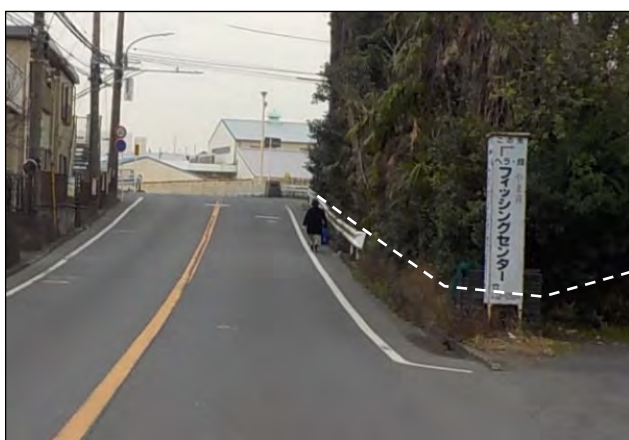
歩道整備・交差点改良 県道川崎町田(緑区青砥町)
