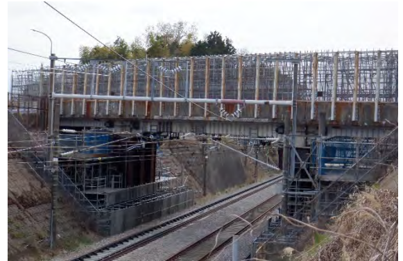
計画的な補修: 第1柳明橋(泉区)
