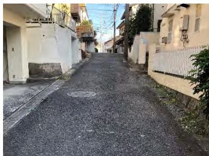
私道整備助成実施前(港北区)
