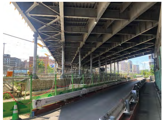
耐震補強工事:新横浜陸橋(港北区)
