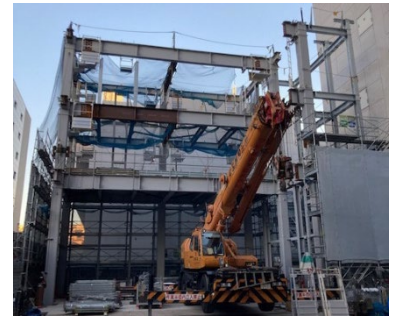
【倉庫棟建設状況】
