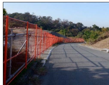
〔写真2 B型バリケード設置状況〕
