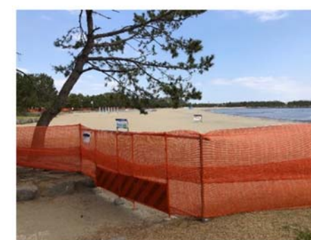
海の公園 柵の設置状況
