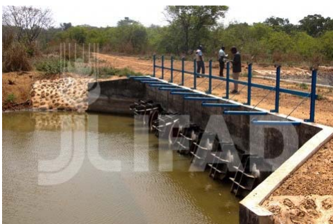
灌漑用水管理ダム建設プロジェクト (ギニアビサウ 2020年)
