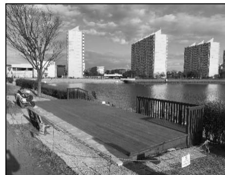
【まち普請事業で整備したウッドデッキ】
