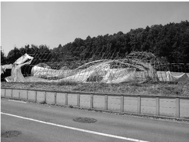
ビニールハウス全壊
