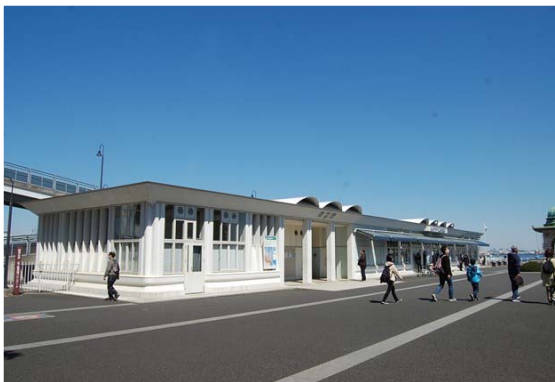
レストハウス全景 トイレや周辺園地の清掃も事業者が実施
