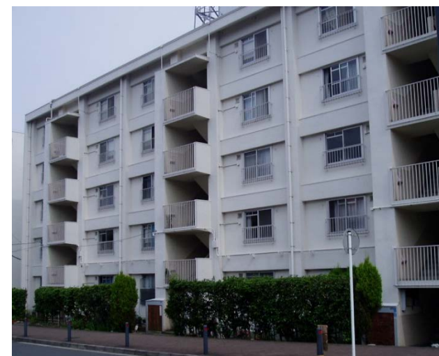
【参考1】瀬戸橋住宅の現況外観写真
