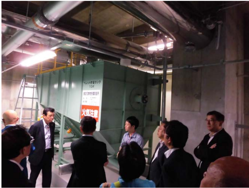
ペレットボイラーについて説明聴取
