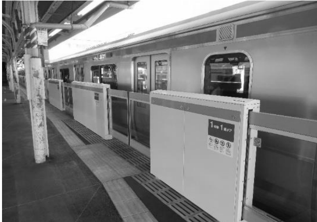
可動式ホーム柵の設置状況 (29年度整備:京浜東北線鶴見駅)
