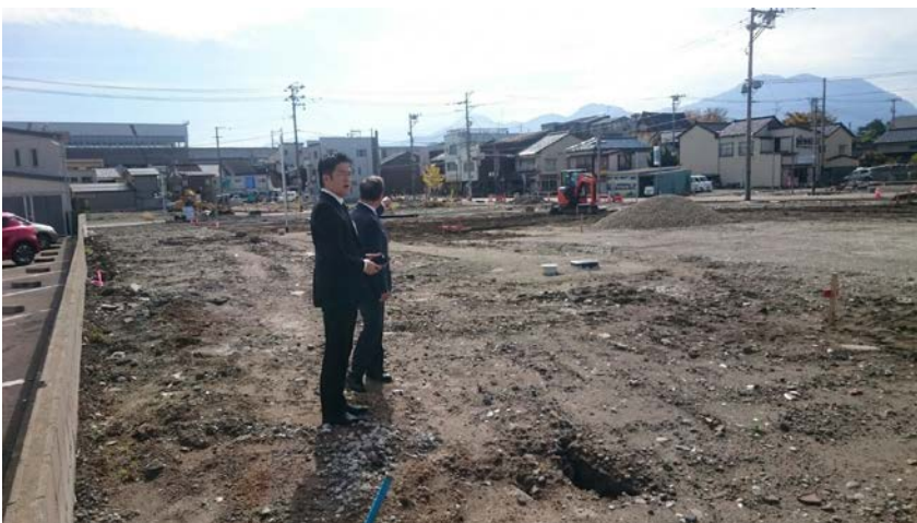
焼け跡を視察。すでに瓦れきや基礎は撤去され、 更地に。一部では、建物の再建が始まっている。
