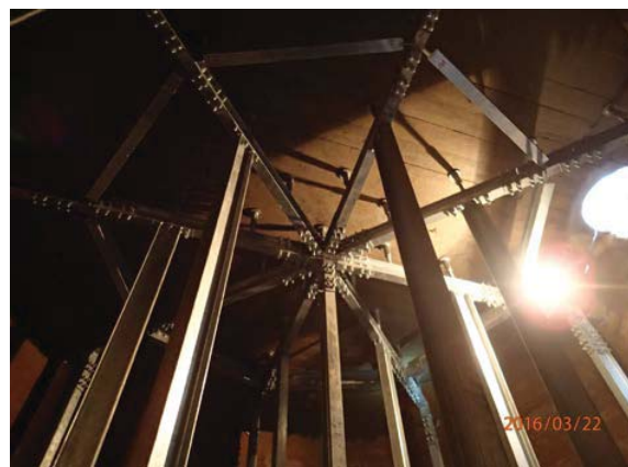
防 火 水 槽 補 強 工 事
