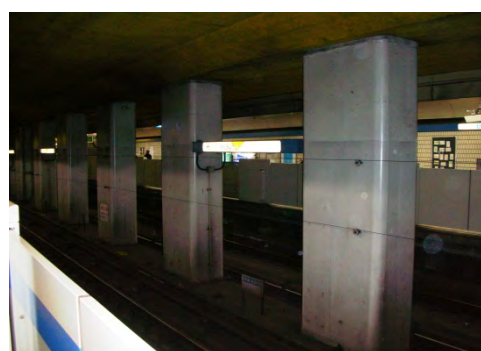
【中柱を補強した開削トンネル】
