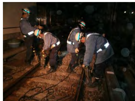
【軌道整備を行う地下鉄保守職員】
