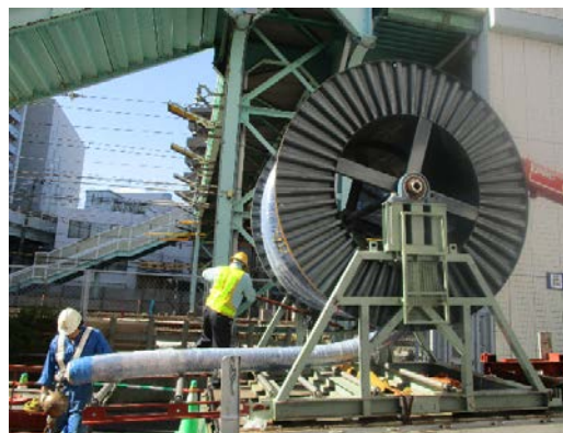
フレキシブルステンレス管を用いた内挿管工法
