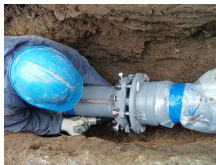
GX形ダクタイル鋳鉄管による更新工事
