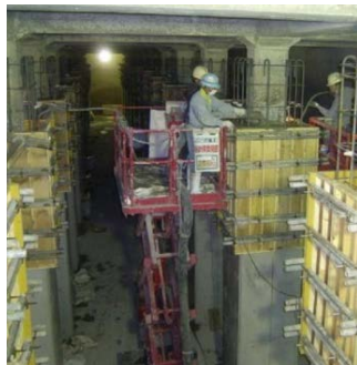
配水池耐震補強工事
