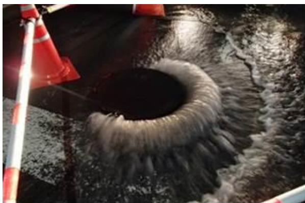
写真1 漏水発生当初の状況
