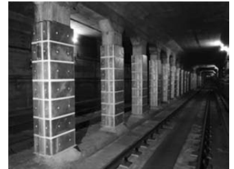
<開削トンネルRC中柱耐震補強>
