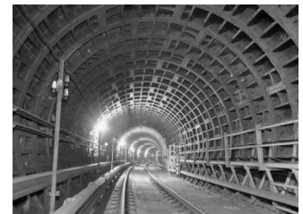
<シールドトンネル>
