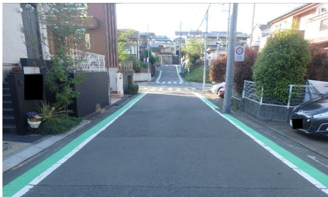
写真3. 28年12月補正の施工例 あんしんカラーベルトの補修（青葉区：あざみ野第二小）
