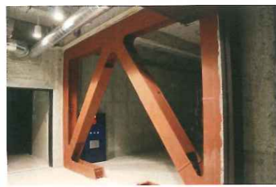
▲耐震ブレースを設置
