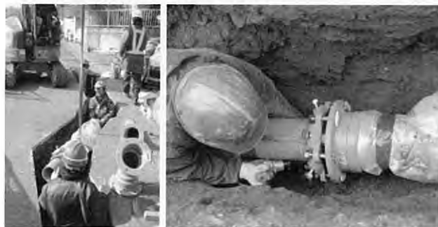
G X形ダクタイル鋳鉄管による更新工事
