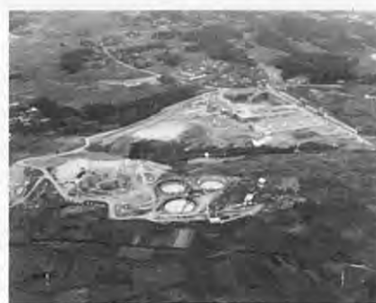
建設中の小雀浄水場 (昭和 40 年 3 月竣工)
