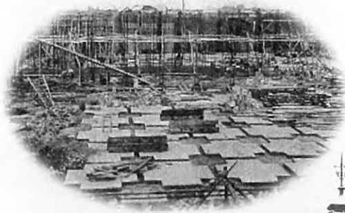
西谷配水池工事
