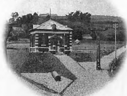
配水施設及び計量器室
