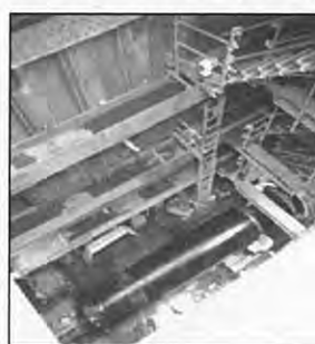
推進工法による工事
