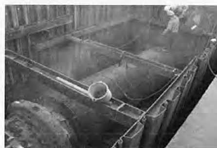
<老朽管更新・耐震化工事>
