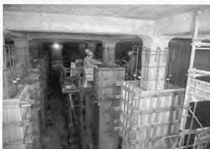
配水池耐震補強工事
