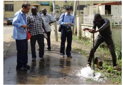
消火栓の状況調査 (ナイジェリア)
