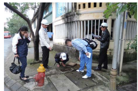
漏水探知による無収水対策(フエ)
