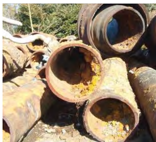
鋳鉄管(CIP) ※赤水や漏水の発生原因
