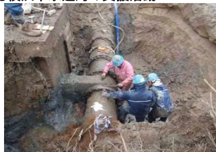
口径600mmの導水管の修繕(茨城県日立市)
