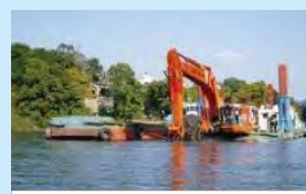
相模湖での土砂除去作業
