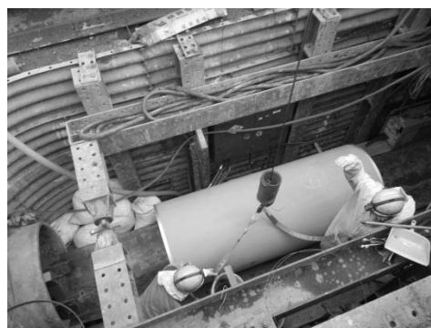
内挿管工法※1による布設状況
