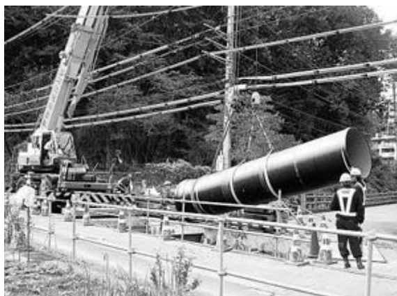
地震に強い水道管への取替工事
