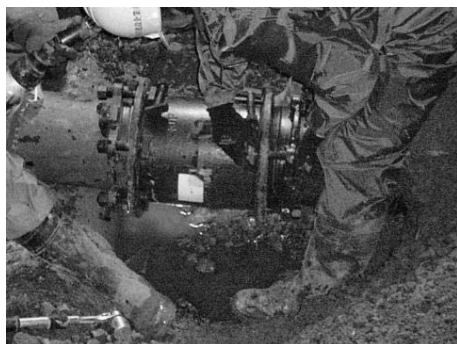
配水管の布設替工事
