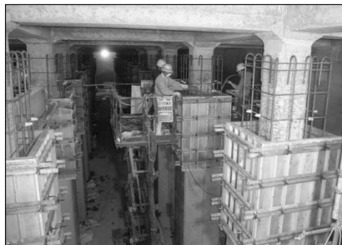
配水池の耐震補強工事
