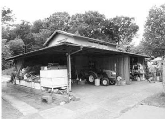
【写真1】農業機械格納庫（戸塚区）
