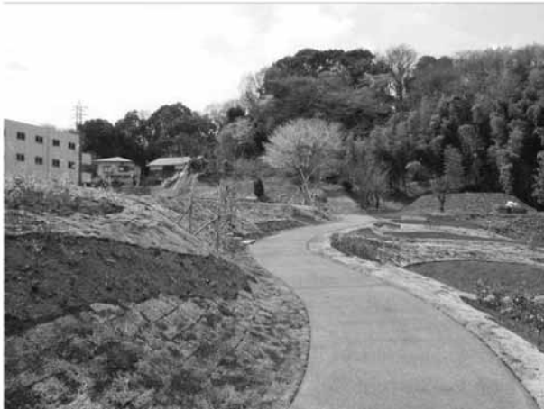
【写真】整備中の農園付公園 （港北区／（仮称）師岡町梅の丘公園）
