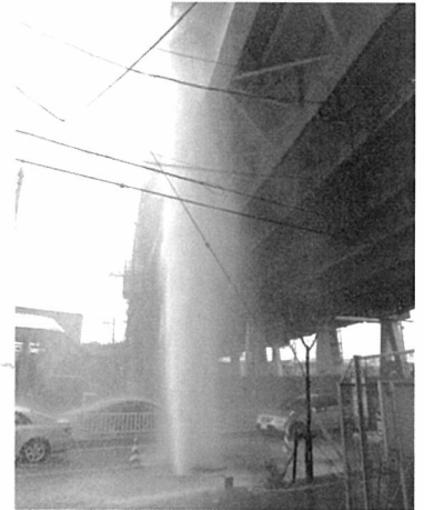
事故発生状況写真
