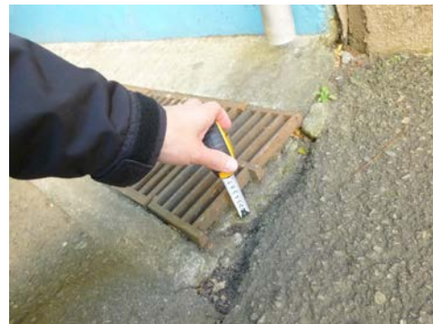
舗装の段差 (宮ヶ谷地下歩道・西区)
