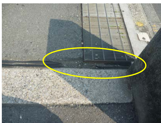
橋梁端部の段差 (港南橋・港南区)
