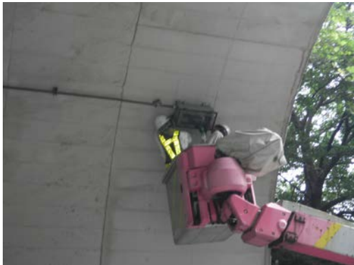
アンカーボルト打ち直し後、照明器具 取付け作業中
