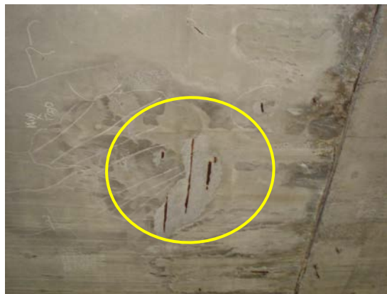
天井部コンクリートの鉄筋露出 (入之谷第1隧道・保土ヶ谷区)
