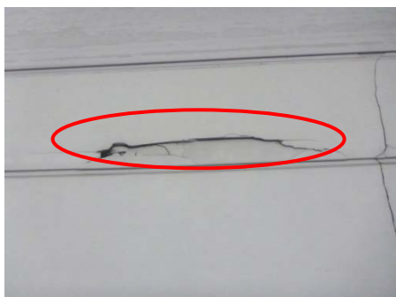
壁板の破損
