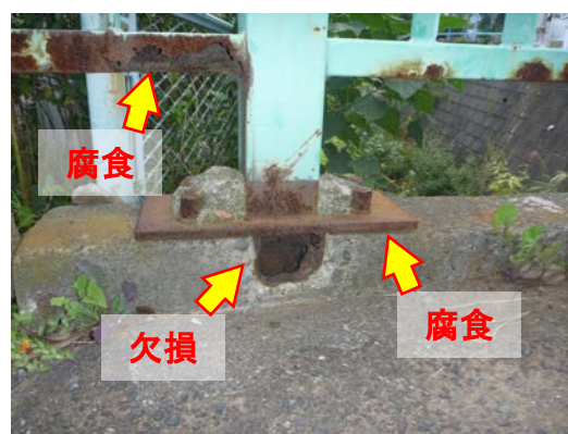
高欄の腐食及び地覆コンクリートの欠損 (神明谷橋 しんめいや ・泉区)
