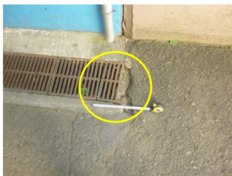
舗装の段差 (宮ヶ谷地下歩道・西区)
