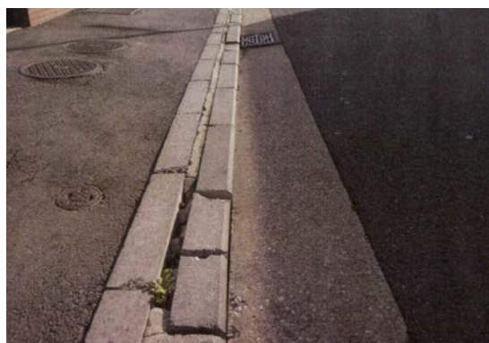
縁石の破損 （南区井土ヶ谷中町）
