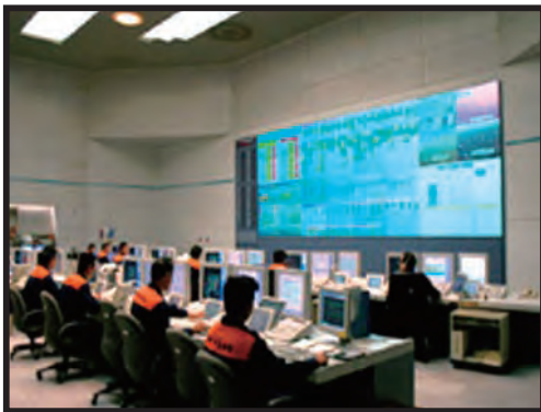
いろいろな情報を見るための画面がある司令室
