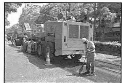
道路の維持・管理(舗装補修)
