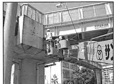
歩道橋の点検
