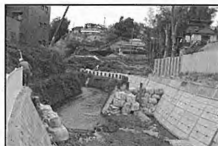
河川の改修(日野川の護岸改修)
