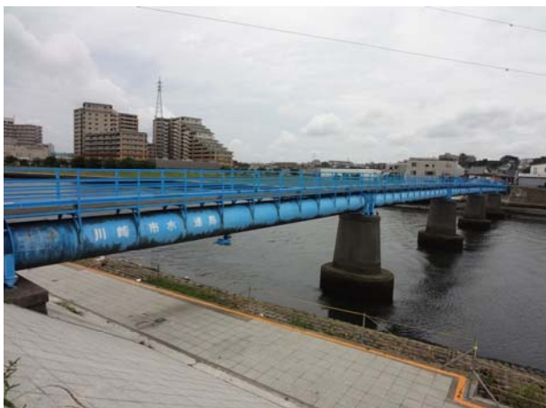
全景 (矢向一丁目側より)
