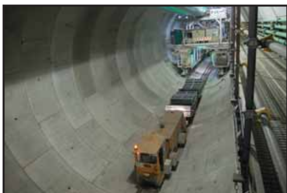
シールドトンネル施工状況
