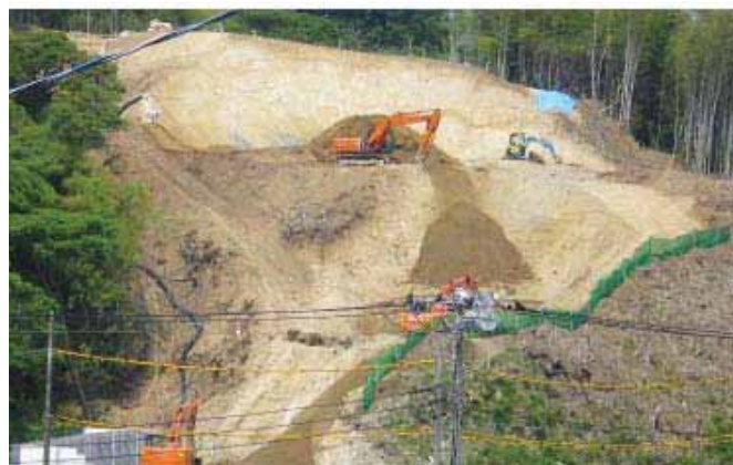
横浜環状南線・上郷公田線(公田地区)の工事の状況
