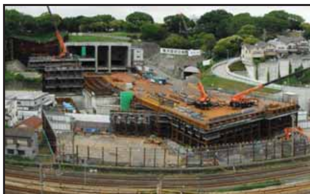
子安台換気所及び鉄道交差部作業構台施工状況
