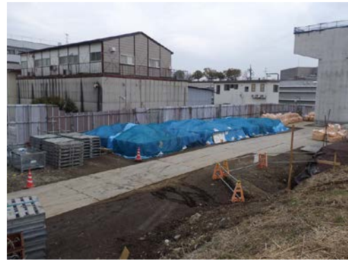
写真2 PCB廃棄物保管状況
