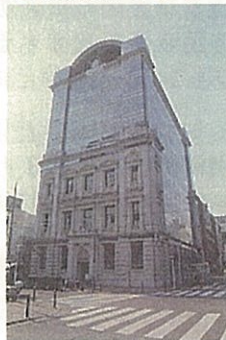
容積緩和制度を 利用した外壁復元 [日本興亜馬車道 ビル]
