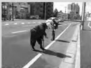
調査状況（マンホールの開閉）
