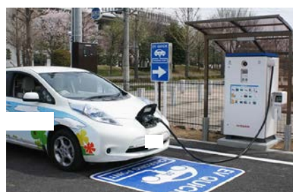
急速充電設備の設置・充電事例
