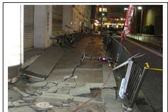
【歩道陥没：西区南幸二丁目】
