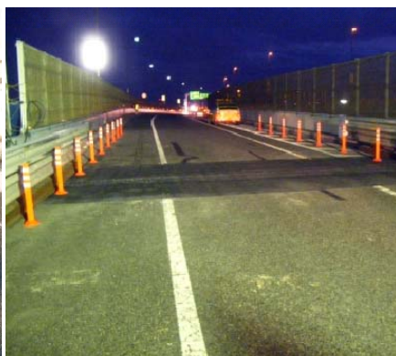
応急復旧状況
