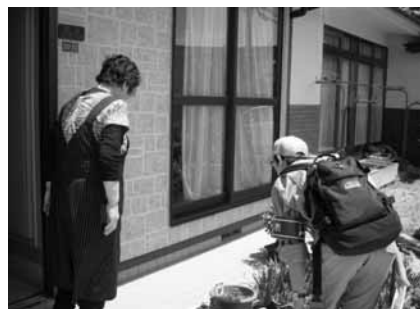
派遣職員による被災地の被害調査の様子
