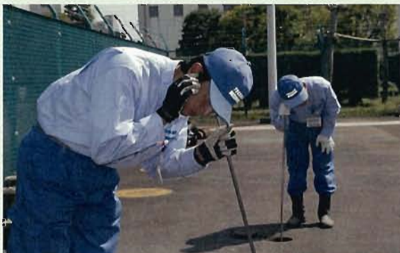
地下漏水調査
