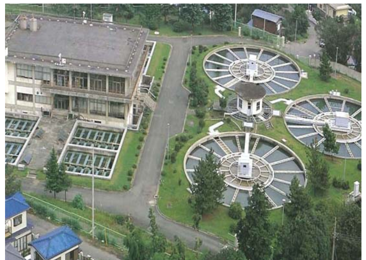
図3 鶴ヶ峰浄水場の現況写真
