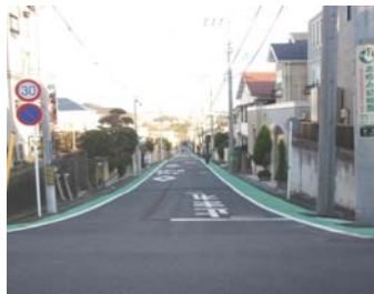
②-2 あんしんカラーベルト事業 路側帯のカー舗装化(港南区)
