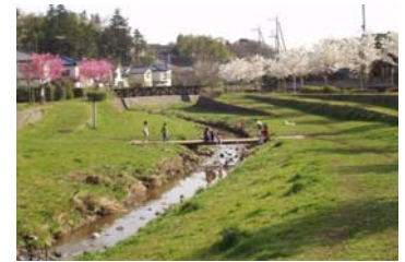
③-2 水と緑のネットワーク 河川環境整備（和泉川：泉区）
