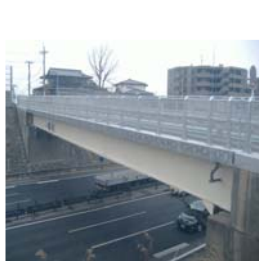
④-1 計画的な施設管理 橋梁補修（跨道橋のコンクリート剥離対策）
