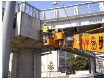
④-1 計画的な施設管理 歩道橋補修（歩道橋の点検）
