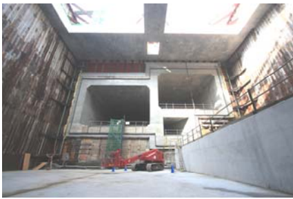
①-1 高速道路の整備 横浜環状北線(新横浜立坑:港北区)
