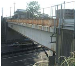
④-1 計画的な施設管理 橋梁補修（跨道橋のコンクリート剥離対策）
