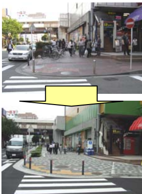
②-1 バリアフリー歩行空間整備 歩道のバリアフリー化(関内駅周辺地区:中区)
