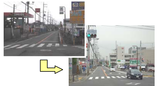
①-3 駅まで15分道路の整備 県道阿久和鎌倉の交差点改良(和泉町地区:泉区)
