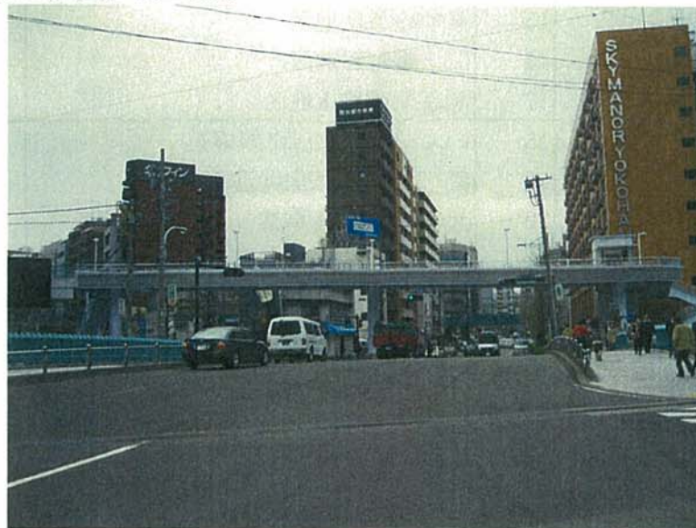
万里歩道橋 竣工写真
