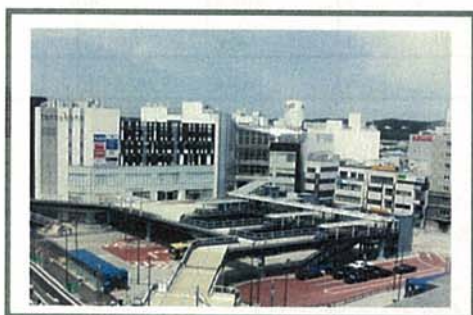
戸塚駅西口第1地区 市街地再開発事業（施行中）
